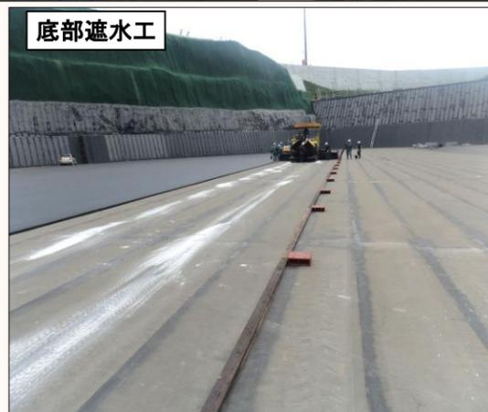
最終処分場が完成間近になってきました。埋立地内の法面部及び底部の遮水工事が完了し、浸出水集排水管の施工を進めています。管理棟（浸出水処理施設）の建築工事も終盤にさしかかり、内部仕上げを行っています。プラント工事においても設備の搬入も概ね完了し、配線、配管の施工を行っている状況です。今後は、試運転に向けて、各施設の機器調整を行っていきます。
