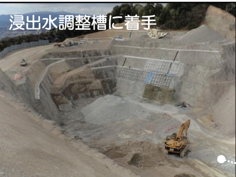
法面保護（かご工）施工状況
