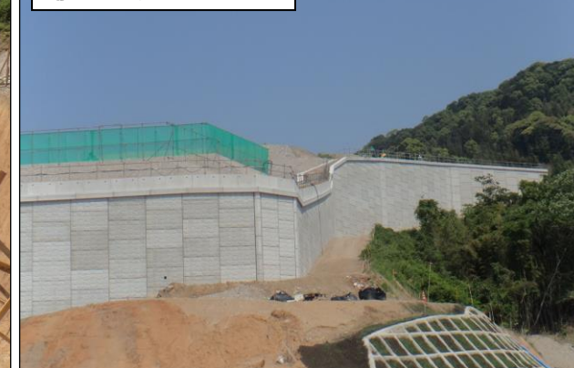
覆土置場擁壁 完成
