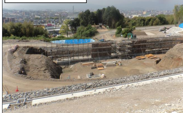
防災調整池C 施工中
