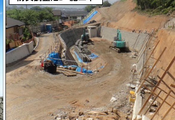
防災調整池D 施工中
