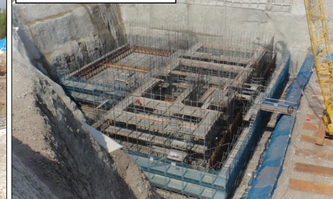
浸出水調整槽 施工中
