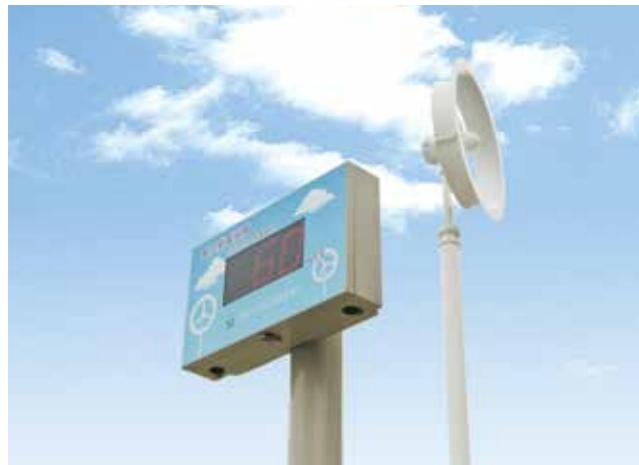
施設内に設置された風力発電設備（風レンズ風車）で電気をつくり、その電気を施設内で有効利用しています。
