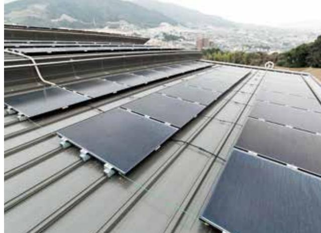
屋上に設置された太陽光発電は、太陽の光を利用して電気をつくるため、二酸化炭素は出しません。グリーンヒルまどかの太陽光発電は、最大 15kW の電気をつくり、その電気を売却しています。
