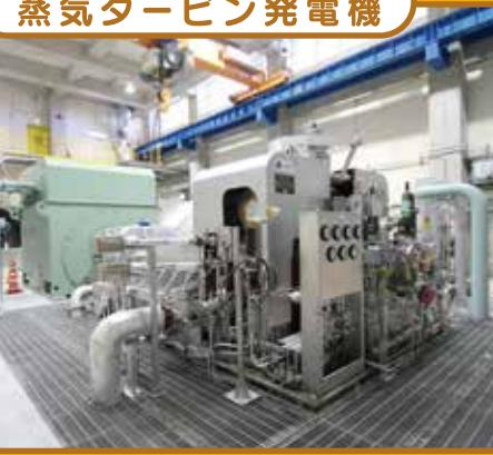
7 ボイラで作った蒸気でタービン発電機を回して電気を作ります。
