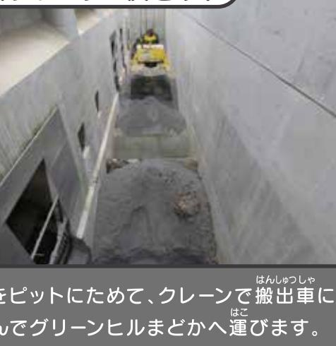
12 灰をピットにためて、クレーンで搬出車に積んでグリーンヒルまどかへ運びます。
