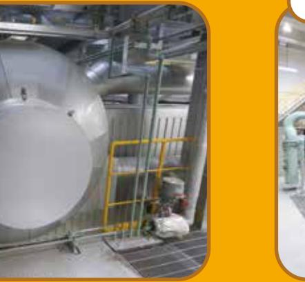
6 焚却炉から発生する排ガスの熱で水を蒸気に変えます。
