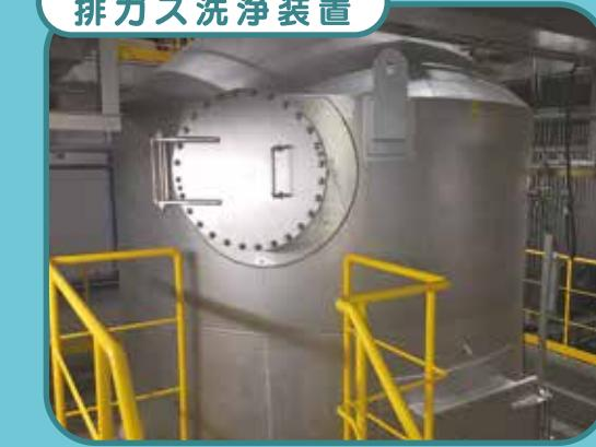
9 排ガス中の薬品や塩素酸化物を触媒の作用により分解して取り除きます。
